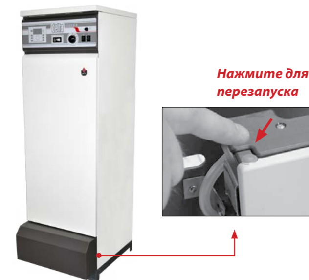
Рис.8 Перезапуск горелки после блокировки
