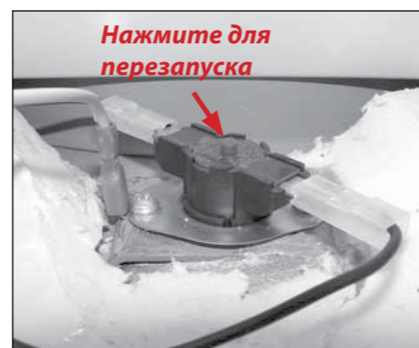
Рис.9 а Перезапуск котла в случае перегрева
