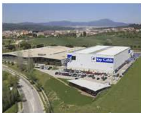
Производственный центр № 1 и автоматизированный склад Top Cable
