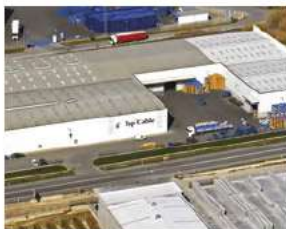
Производственный центр № 3 Top Cable
