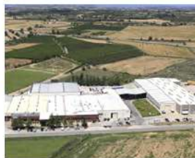
Производственный центр № 4 Top Cable
